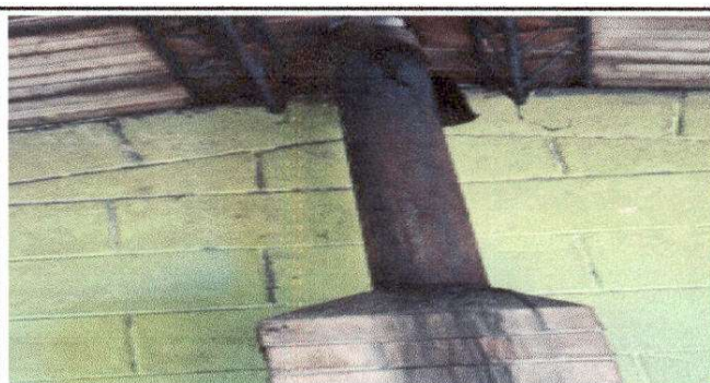
Foto 5: Reparación de chimenea de concreto
