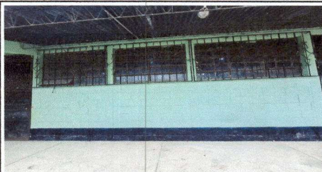
Foto 4: Pintura en muros Exteriores e Interiores
