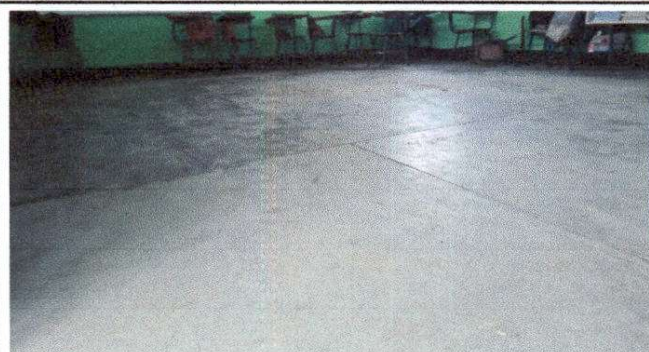
Foto 3: Sustrucción de piso de cemento liquido (por Ceramico)
