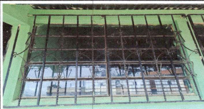
Foto 2: Sustrucción de balcones de metal
